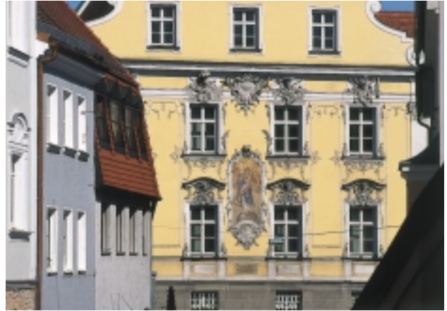
Regierunqsgebäude im Straubinger Herzogsschloss
