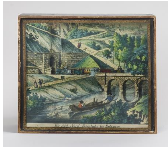
Das Sand-Werk zum Burg-Berg-Tunnel
