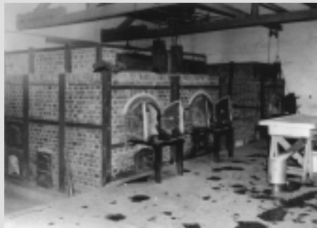
2501 Öfen im großen Krematoriumsgebäude („Baracke X“)
