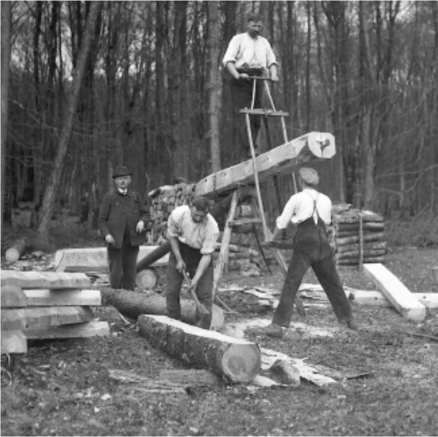
Mit dieser kühn anmutenden Sägekonstruktion wurden gleich im Wald Schwellen für den Eisenbahnbau angefertigt. Einseitlich gesägte Model wurden mit der Axt sauber geschlagen (vorne), mit der Gestellsäge besäumt und längs eingeschnitten (Mitte) und für Trocknung und Abtransport gestapelt (links).
