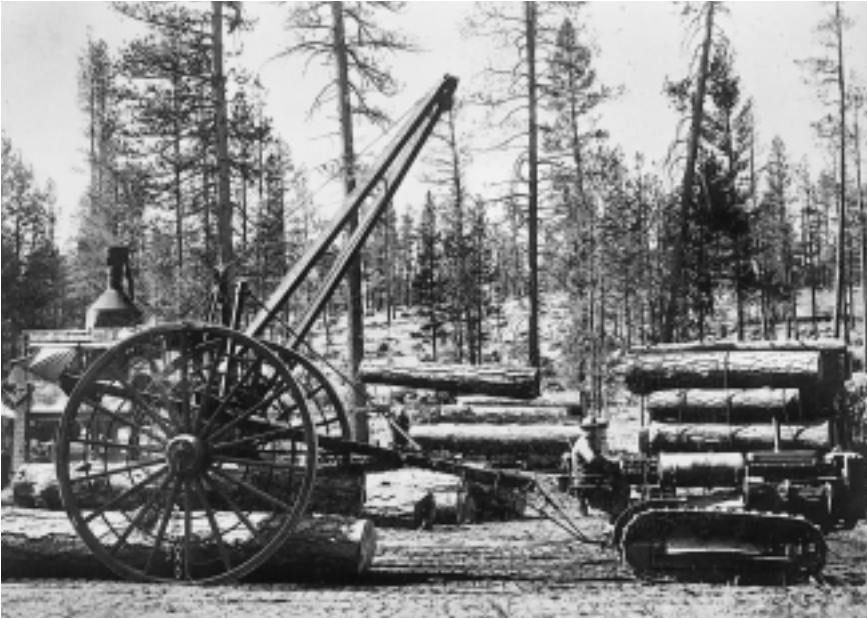
Das Holzrücken, also der Abtransport des Holzes, stellte zu allen Zeiten eine Herausforderung dar. Erst in den 1920er Jahren wurde die Muskelkraft durch Maschinen ersetzt. Mit dem Rückbogen (links) wurden die Holzblöcher in Form von Stammabschnitten nach mittelalterlichem Kranprinzip herausgeholt und mit dem Schlepper (rechts) bewegt.
