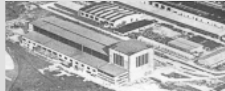
2807 Produktionshalle der Zeppelin-Werke, undatiert Privatfoto KZ-Häftlinge stellten Teile der V2-Rakete in dieser Halle her. Sie wurde Mitte 1944 durch Luftangriffe zerstört.
