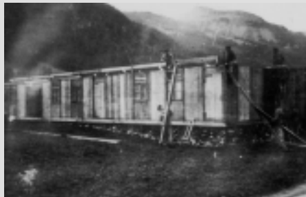
2752 Die polnischen Häftlinge Tadeusz Guzenda, Stefan Gabryl, Marcin Gronowski und Andrzej Burzawa beim Barrackenbau für das SS-Lager Birgau, 1943. Foto: Andrzej Burzawa KZ-Gedenkstätte Dachau In Birgau bei Oberndorf waren von Juli 1943 bis April 1945 etwa 25 KZ-Häftlinge beim Bau eines SS-Abstellplatzes, bei der Lawinenbeeidigung und bei Transportarbeiten eingesetzt.
