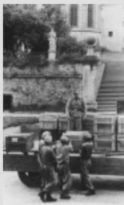
2756 Häftlinge bei Ladearbeiten im Stiftshof St. Lambrecht, undatiert Thaur, Tirol 1942-1945 waren etwa 100 Häftlinge in von der SS beschlagnahmten Stift St. Lambrecht in der Steiermark untergebracht. Sie arbeiteten zum größeren Teil beim Bau einer Wohnsiedlung. Im Herbst 1942 wurde das Kommando dem KZ Mauthausen zugeordnet.
