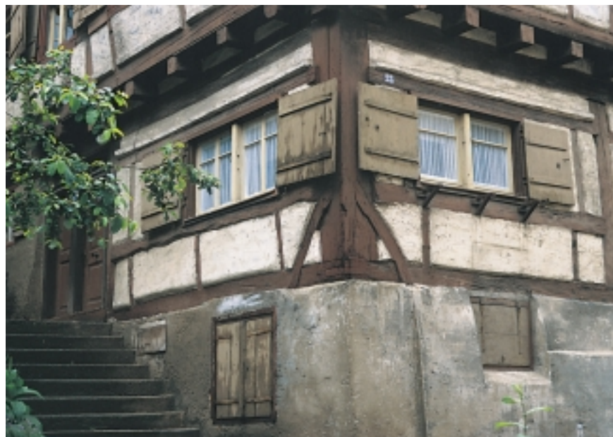
Holz in der Architektur: Das Fachwerk verleiht den alten Städten in Schwaben und vor allem in Franken ihr charakteristisches Gesicht. Dieses Haus in Biberrach ist mit seinem gemauerten Halbkeller, der „Weberdunke“, als ehemalige Wohn- und Arbeitsstätte eines Webers zu erkennen.
