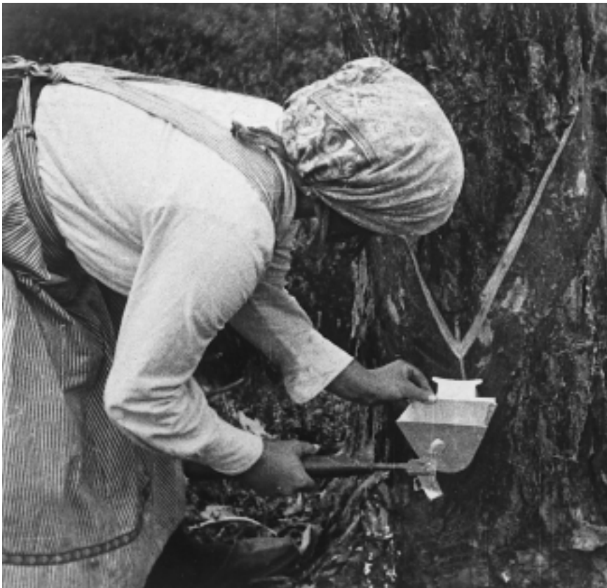
Aus dem Harz der Nadelbäume wurde Terpentinöl gewonnen. Trotz der sich rasch entwickelnden Chemieindustrie wurde noch bis in die 1950er Jahre umfangreich „gepechelt“. Im Prinzip basierte aber auch das hier dargestellte „Verfahren nach Bark 1926“ auf Jahrhunderte alten Traditionen.
